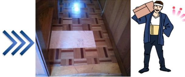
補強してリフォームする方法ですが、まず大工さんの登場です。フカフカ部分を切り取り、床の骨組みを増やして入れ、ベニヤでフタをします。
