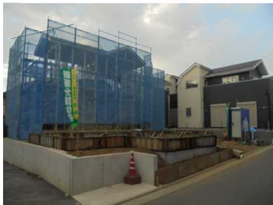
● 右手奥に見えるのは完成した4号棟！ ● 左奥は上棟したばかりの2号棟。 ● 手前の1号棟も基礎工事が完了しています。
