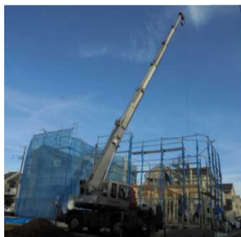
青空の下、4号棟上棟！
