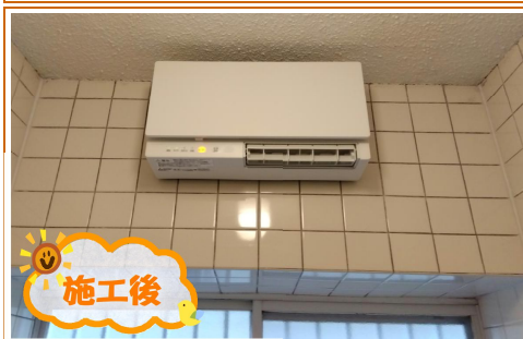
カバーで配線を隠すよう施工 ☆
